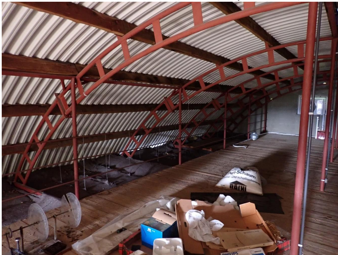
Půda na hlavní budově s viditelnou nosnou trubkovou k-cí střechy
